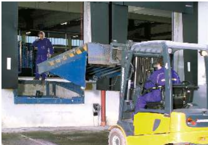
Alte Ladebrücke ausbauen, evtl. Grube anpassen (z. B. mit Montageplatten oder Konsolen)
