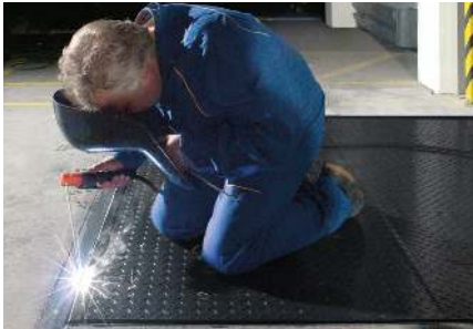
An die Randwinkel anschweißen – fertig!
