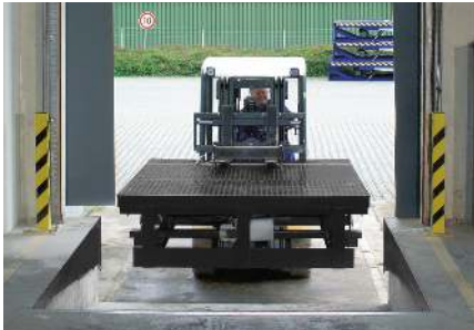
Neue Ladebrücke einsetzen
