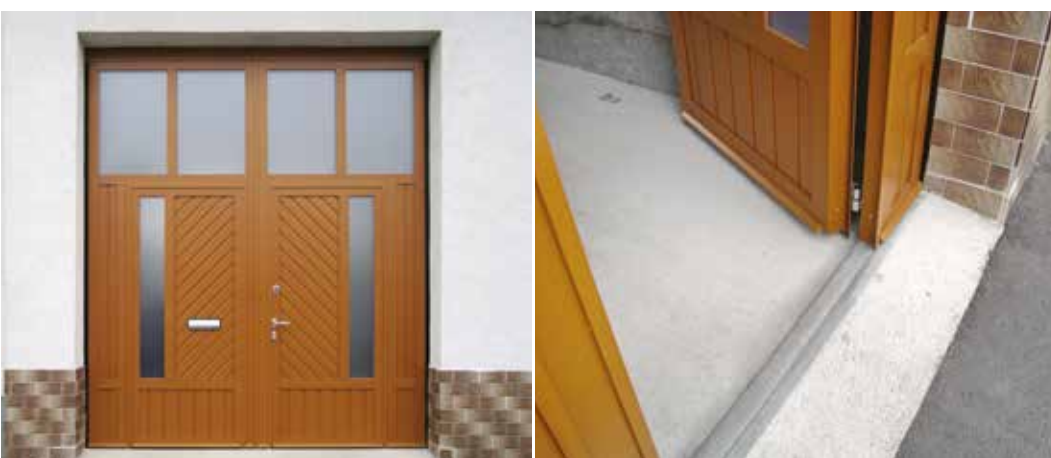
Gehtüre mit einer niedrigen Schwelle aus Edelstahl
