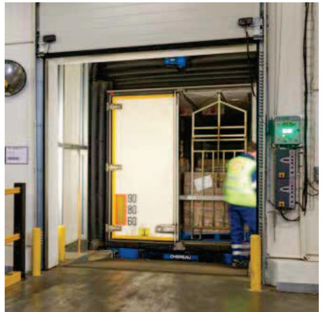
Mit dem DOBO-System kann der LKW mit geschlossenen Türen andocken und diese nach dem Öffnen des Tores in der Halle öffnen und abstellen.
