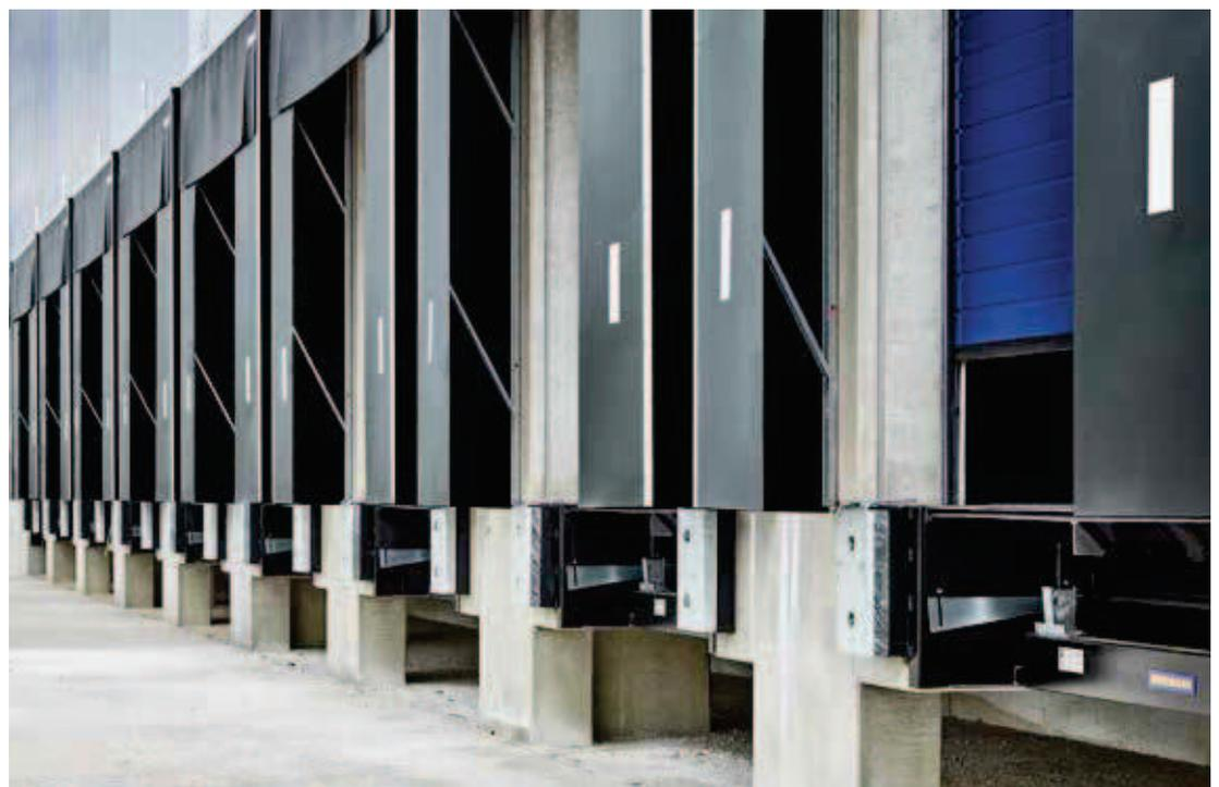
OBEN. Anfahrpuffer DB15 und DB20 aus Gummi oder PU schützen vor Beschädigungen durch Andockkräfte.
