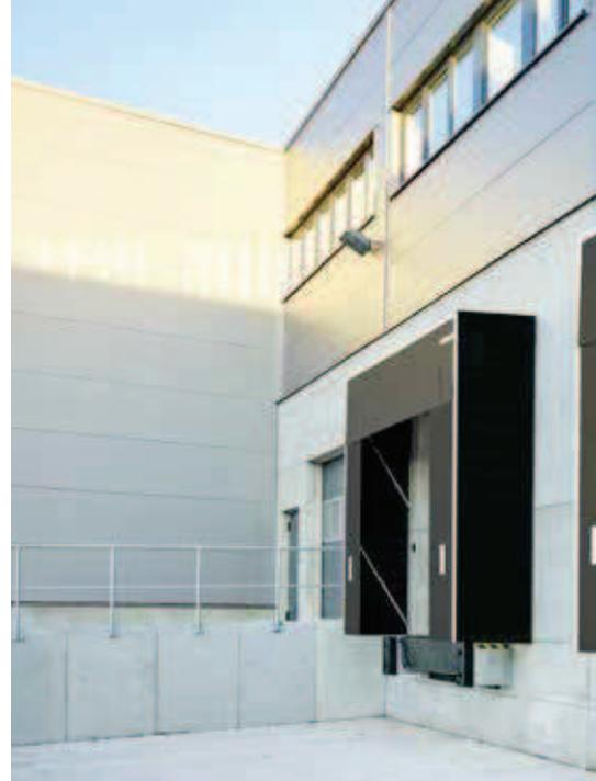
**LADEBRÜCKEN.** Die optimale Planung der richtigen Ladebrücken erhöht die Effektivität in jedem Logistikunternehmen. Wählen Sie die Rampenhöhe so, dass der Höhenunterschied zur LKW-Ladefläche möglichst gering ist. Berücksichtigen Sie auch die vertikale Bewegung des Fahrzeugs, z. B. durch den Federweg beim Be- und Entladen oder bei Wechselbrücken die Abstellhöhen.
